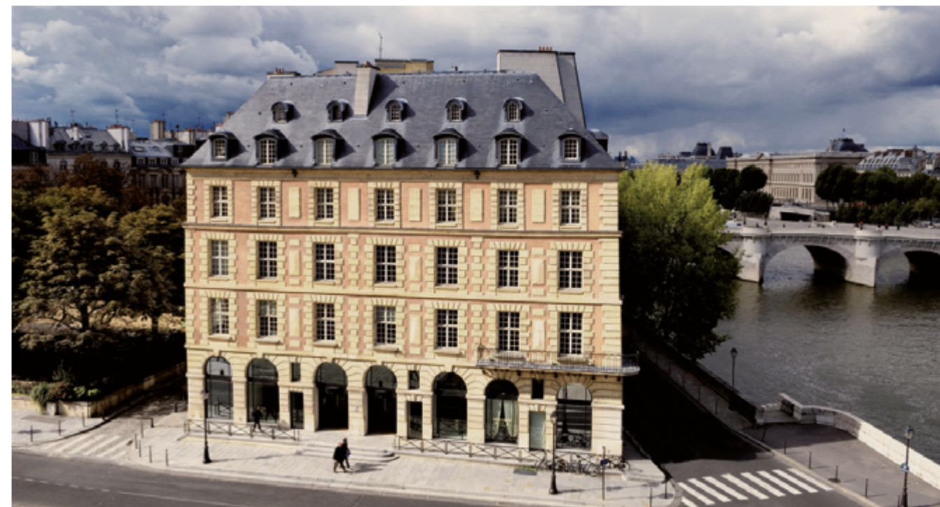
La Maison du barreau
