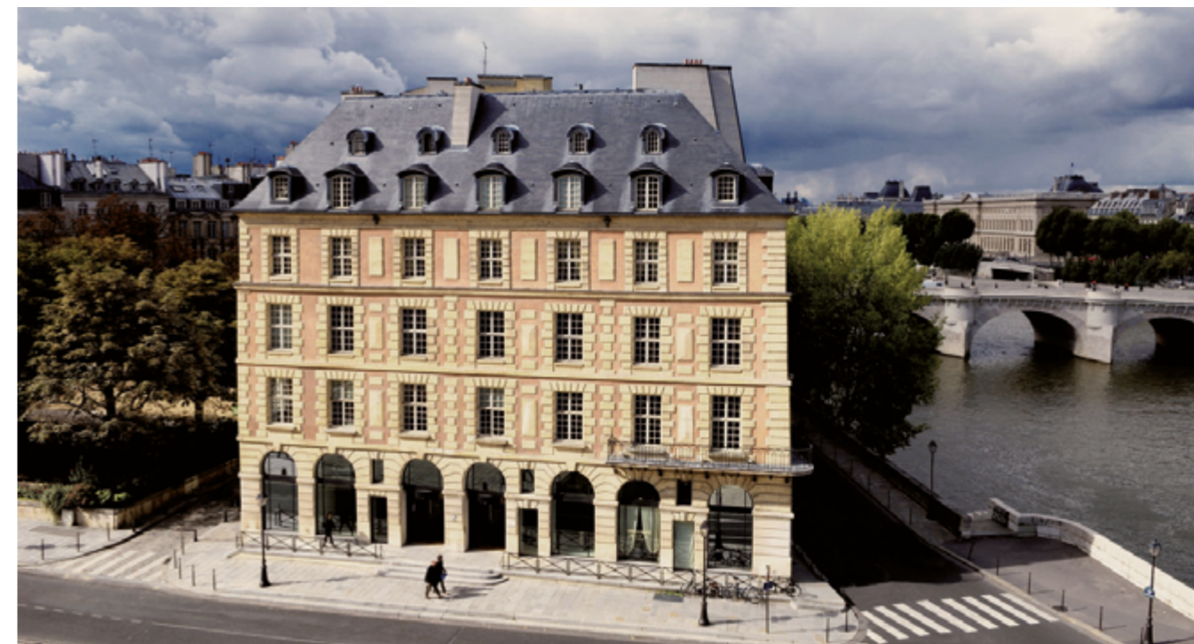
La Maison du barreau
